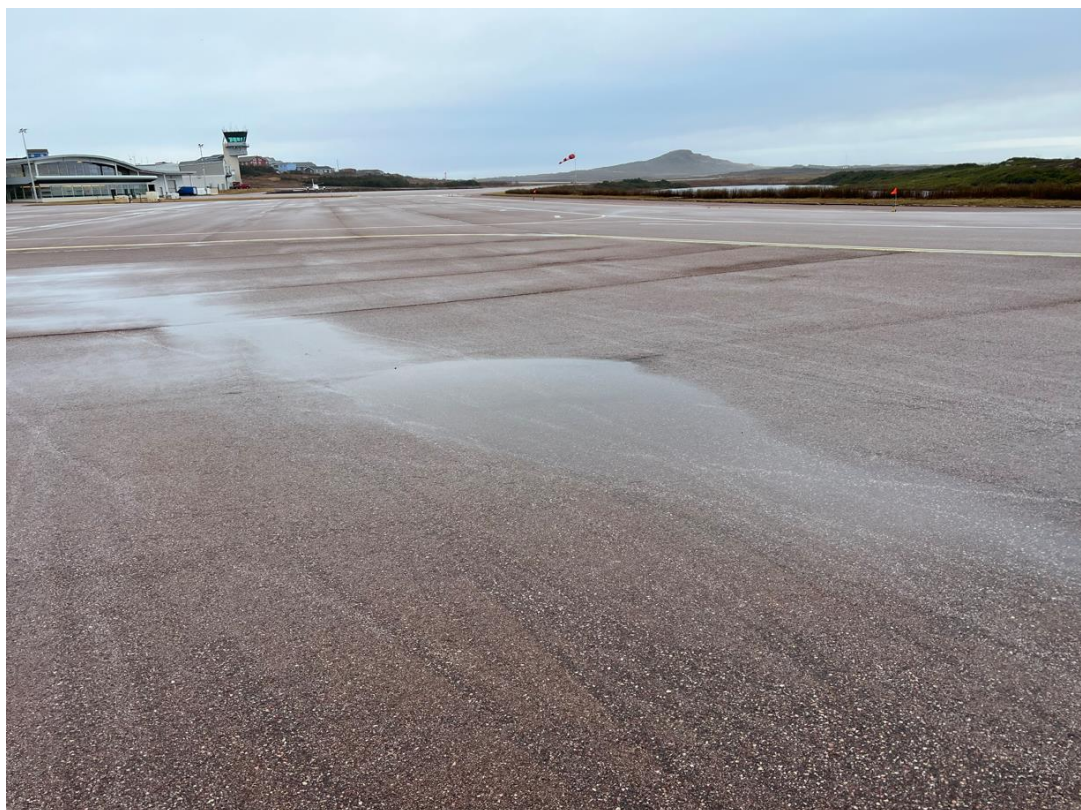
Flache + fissures de retrait
