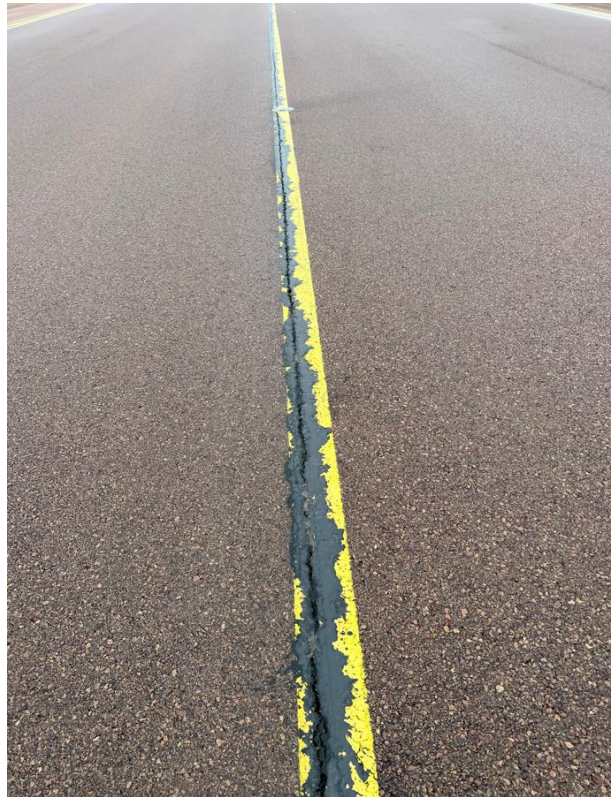
Fissure de joint pontée ouverte
