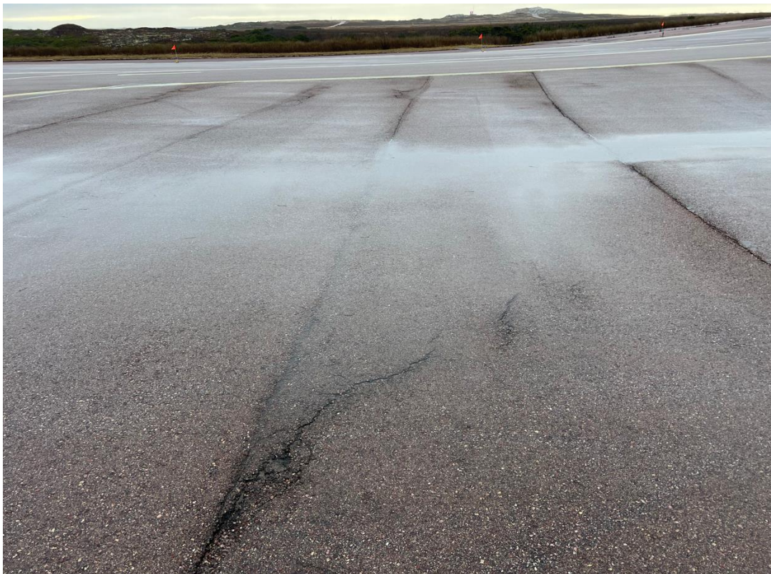
Fissures de joint et faïençage de retrait
