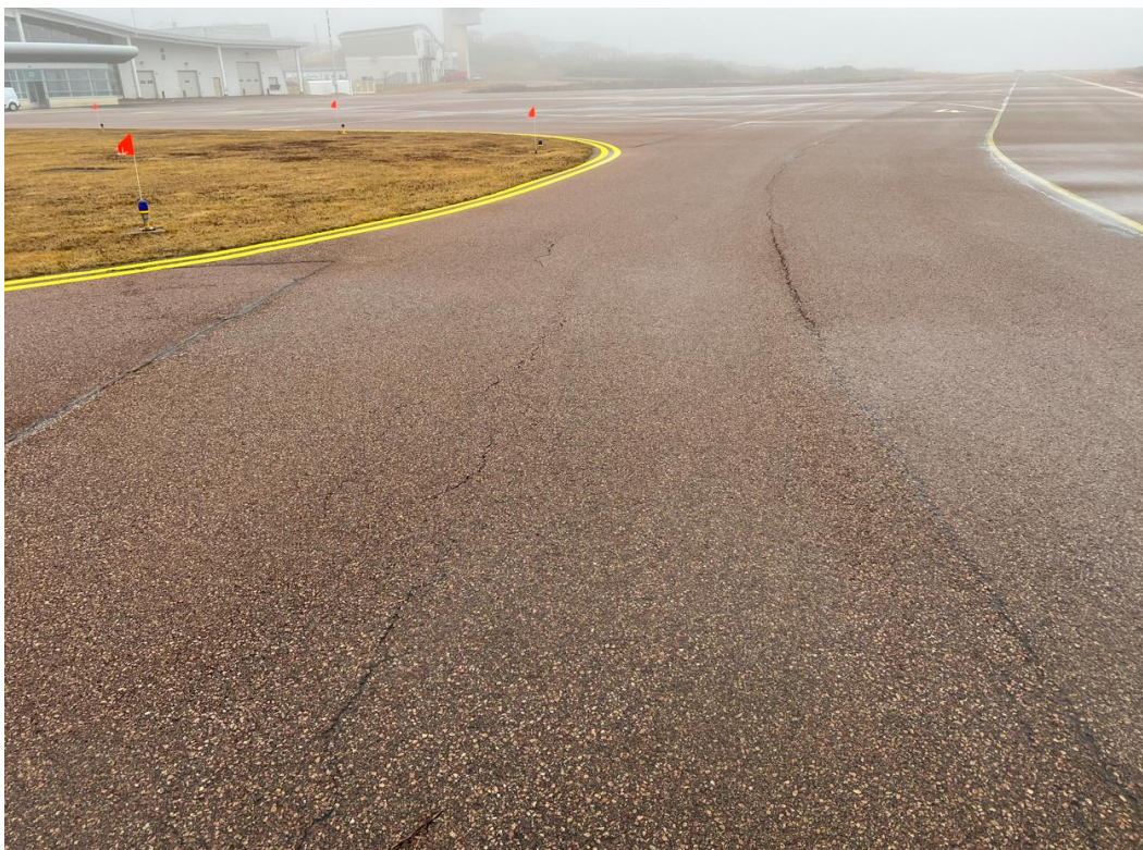
Fissure de joint, de retrait et de fatigue
