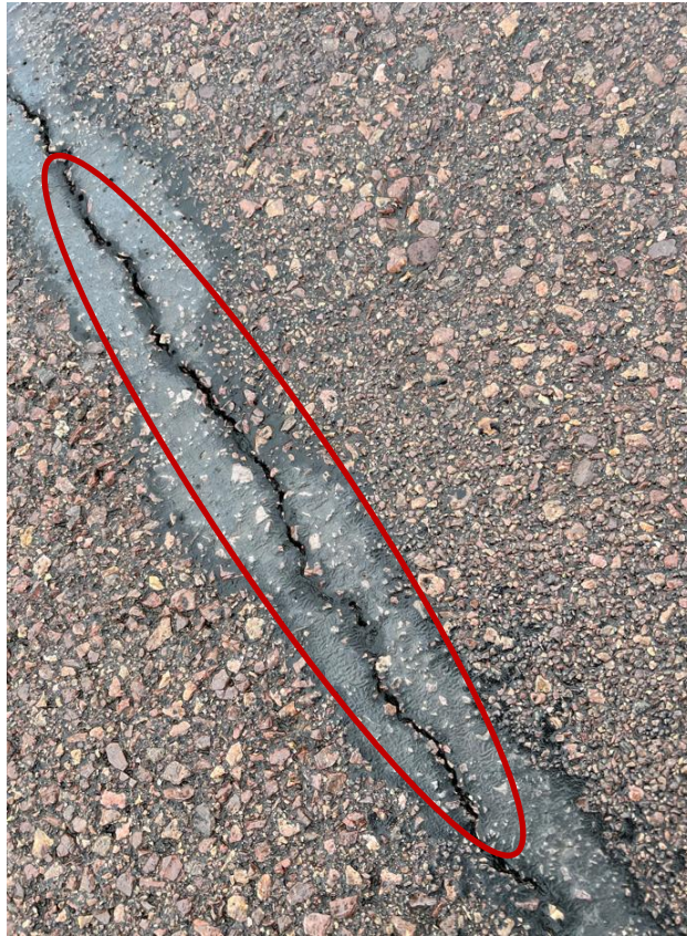
Fissure de joint pointée et rouverte
