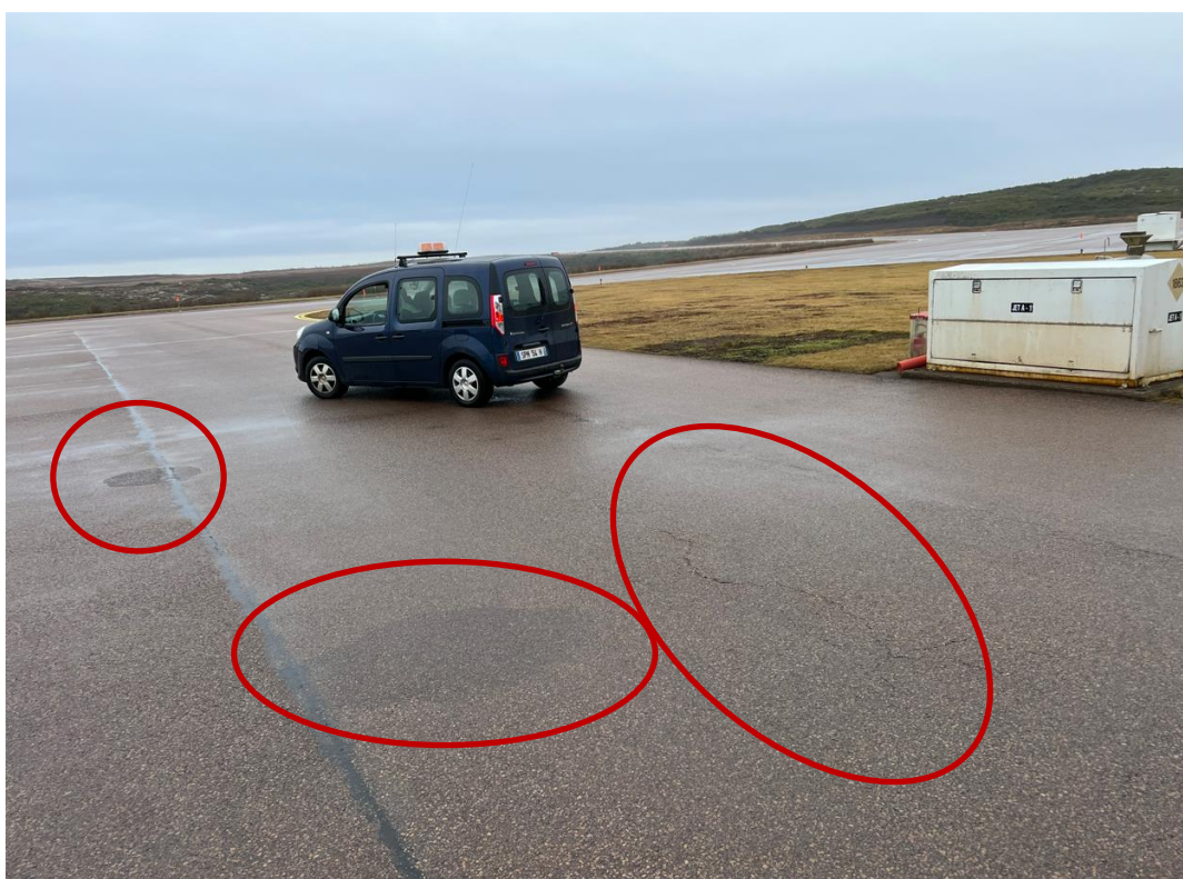
Faïençage de retrait et contamination
