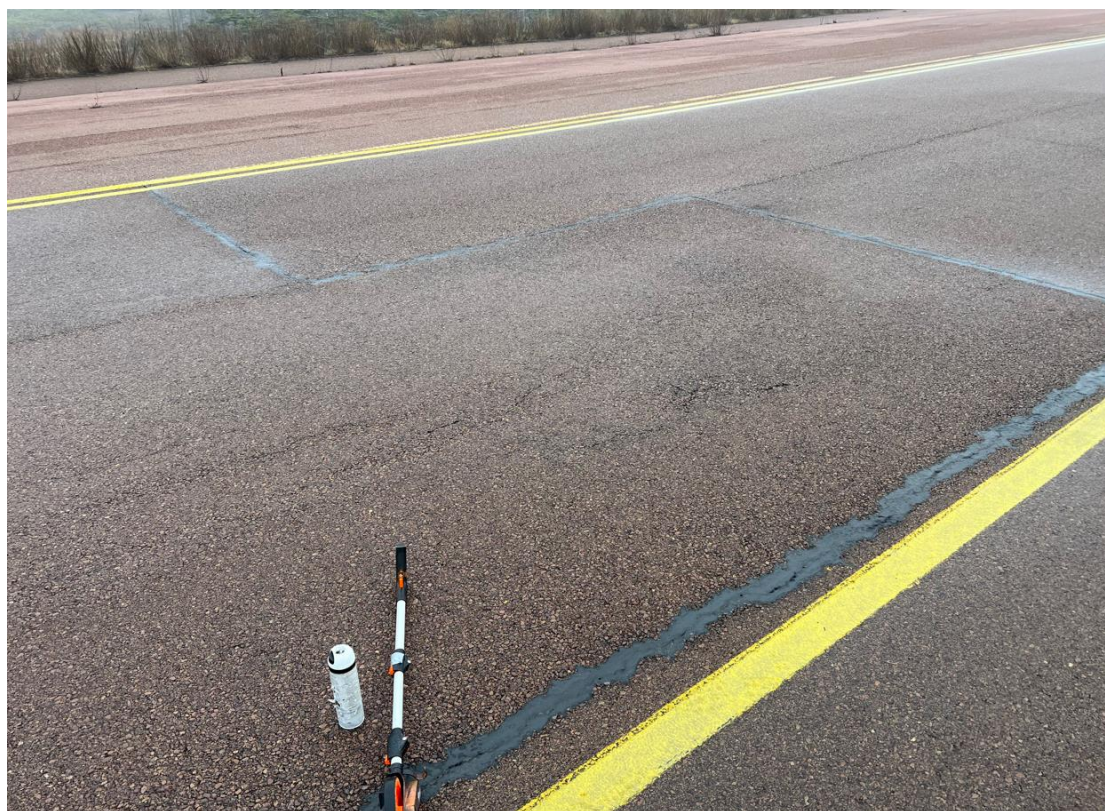
Faïençage de fatigue au niveau de joint de reprise transversal
