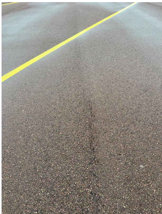
Fissure de fatigue
