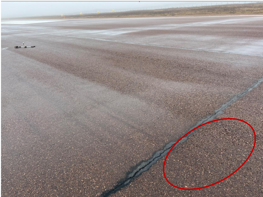
Fissure de joint transversale pontée ouverte et léger Faiençage de fatigue au niveau de la reprise
