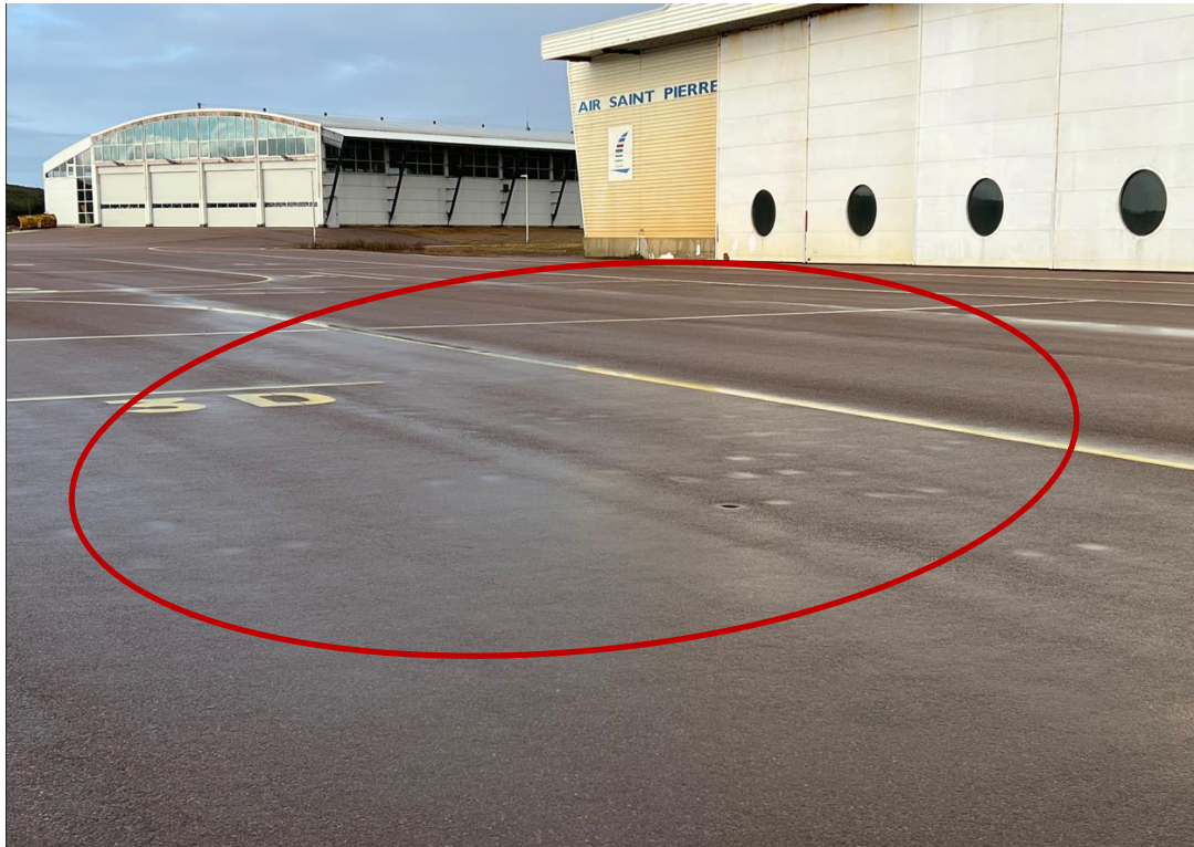
Empreintes/poinçonnement et fissure de joint
