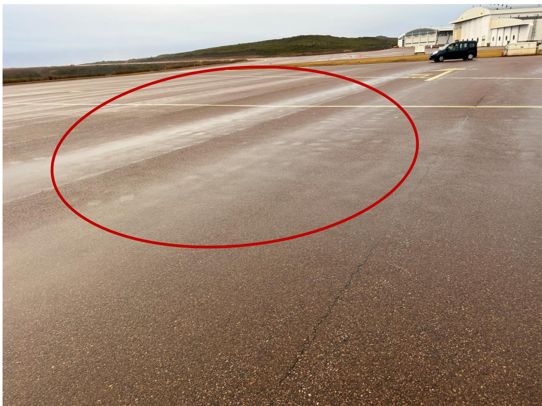
Empreintes/poinçonnement et fissure de joint
