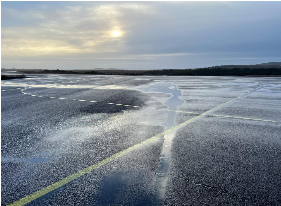
Flache + fissures de retrait
