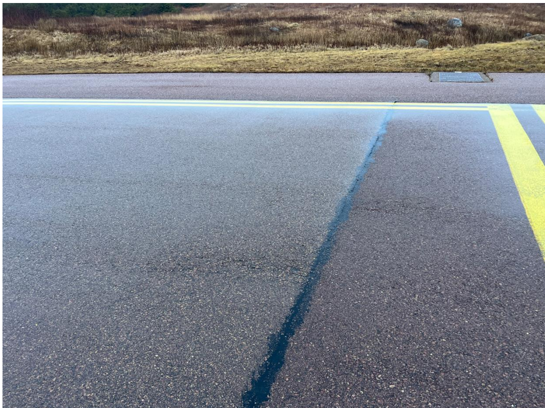
Faiénçage de fatigue et fissure de joint au niveau du joint de reprise transversal
