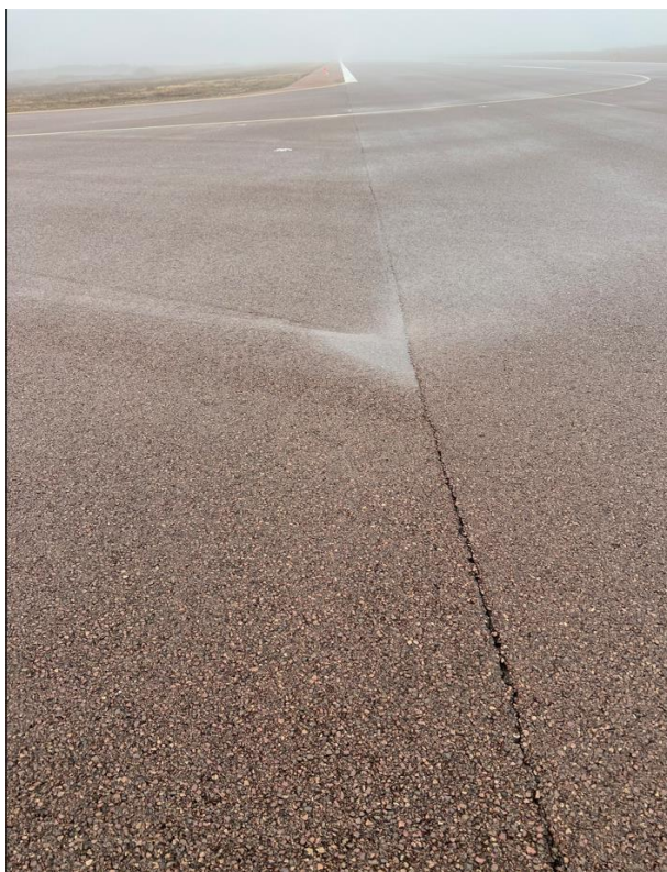
Fissure de joint et flache
